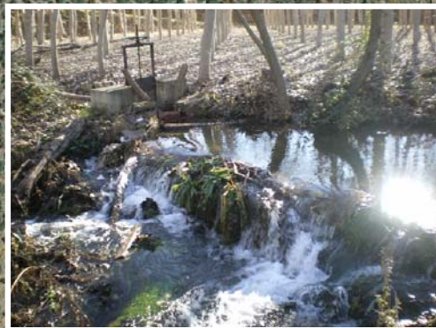
32.- AZUD "PRESA DEL BATÁN, DE LA JUANA"
